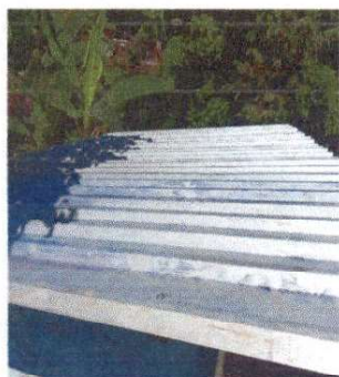
Foto1: Sustitución de lámina, por lamina troquelada en baños
