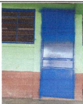
Foto 3: Mantenimiento de estructura (lijado, cambio de tubo, cepillado, sugerencias, aplicación de pintura) en aula
