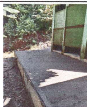
Foto 5: Sustitución de piso de concreto en baños
