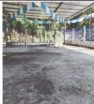
Foto 10: Reparación de tubo HG y malla galvanizada en el perímetro del centro educativo.
