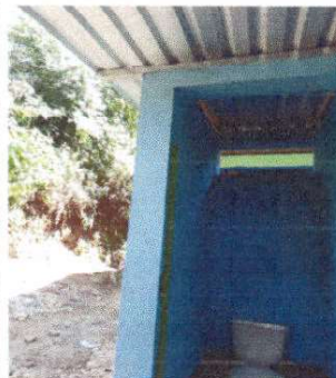
Foto 2: Sustitución de estructura de soporte de madera por metal en baño.
