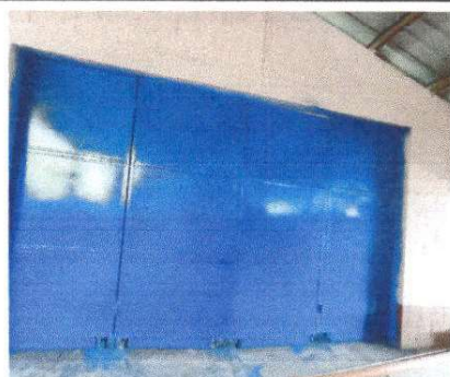
Foto 9: Mantenimiento de portones de metal en ingreso de la escuela
