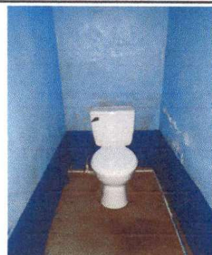
Foto 8: Sustitución inodoro en baños
