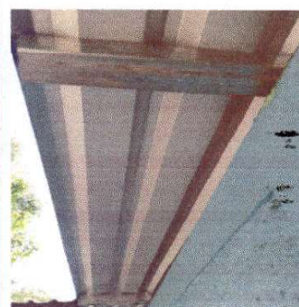
Foto 2: Sustitución de estructura de soporte de madera por metal en baño.
